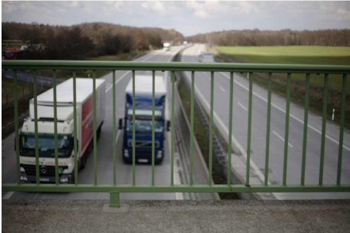
Autobahnbrücke BAB 14 in Richtung Seelingstädt
