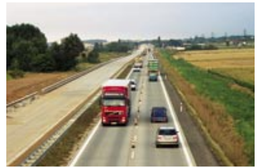
Ausbau der Autobahn A 4 bei Legnica
