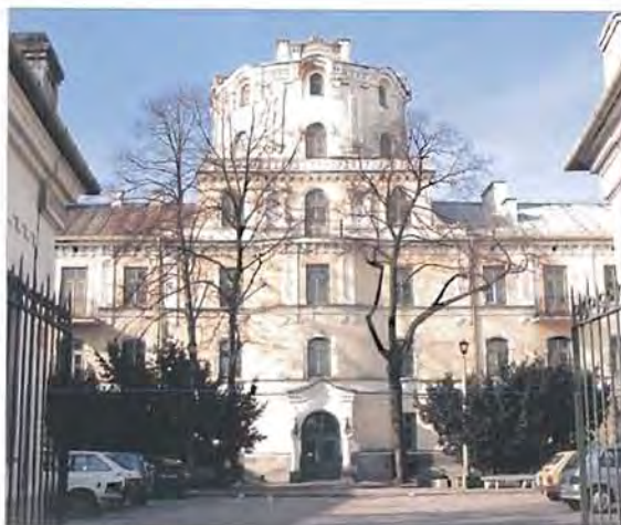
Dawny dwór Sobieskich, stan po wielokrotnej przebudowie (ST)
