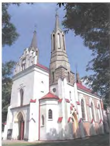
Kościół pw. św. Marcina w Lublinie - Zemborzycach (MZ)
