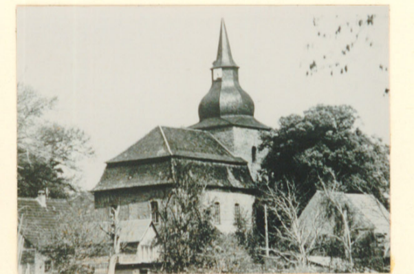
DIE BAROCKE KIRCHE VOR DEM BRAND UND DER ANSCHLIESSENDEN TEILERNEUERUNG.
