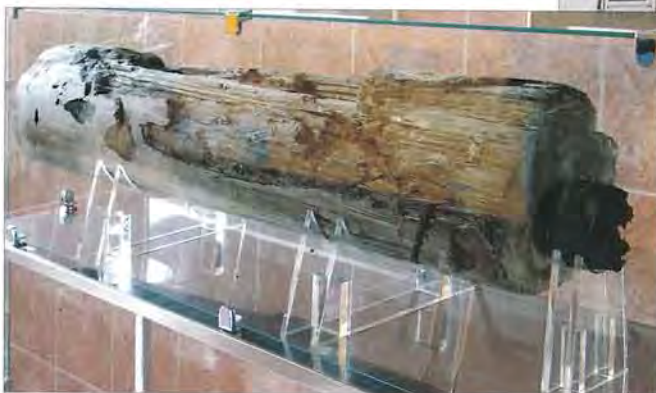
Rura wodociągowa ekspozowana w Stacji Centralnej MPWiK (MZ)
