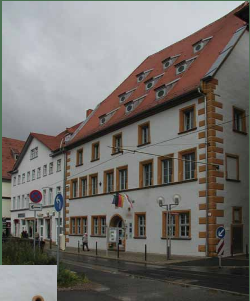
Abbn.: Das Geleitshaus Erfurt nach der Sanierung.
